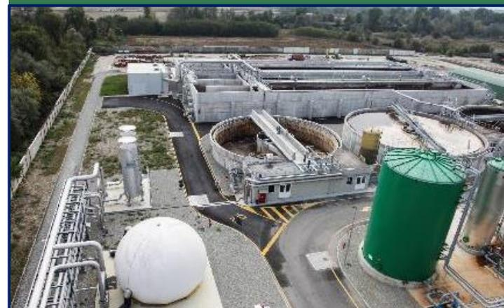
L'impianto, attivo 24 ore su 24 tutto l'anno e realizzato con nuove tecnologie, **tratta, recupera e ricicla la totalità delle acque di scarico** dello stabilimento attraverso un **processo ad osmosi inversa**.
